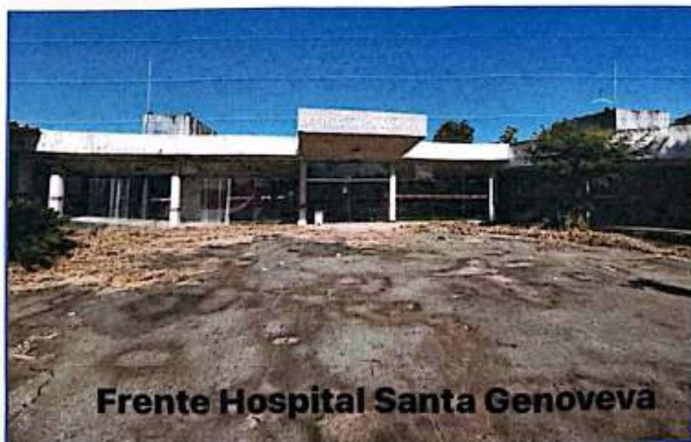
3- Faixada da frente do Hospital Santa Genoveva
